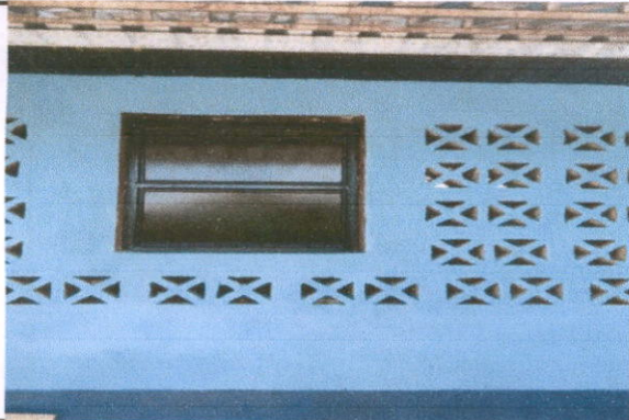
Foto 3: Sustitución de ventanas de madera por metal en cocina.
